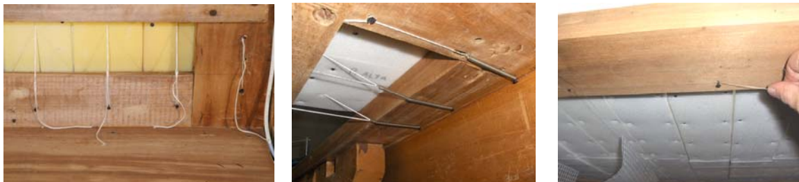
Figure 41, 42 e 43 . il tensionamento di fili di nylon
