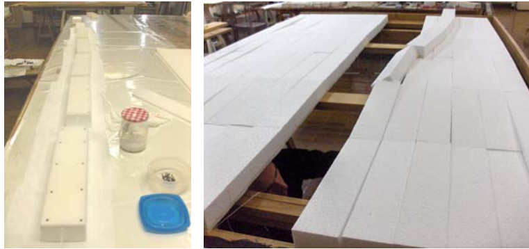
Figure 36 e 37 . Fissaggio completo delle file dei mattoncini sul telaio-
